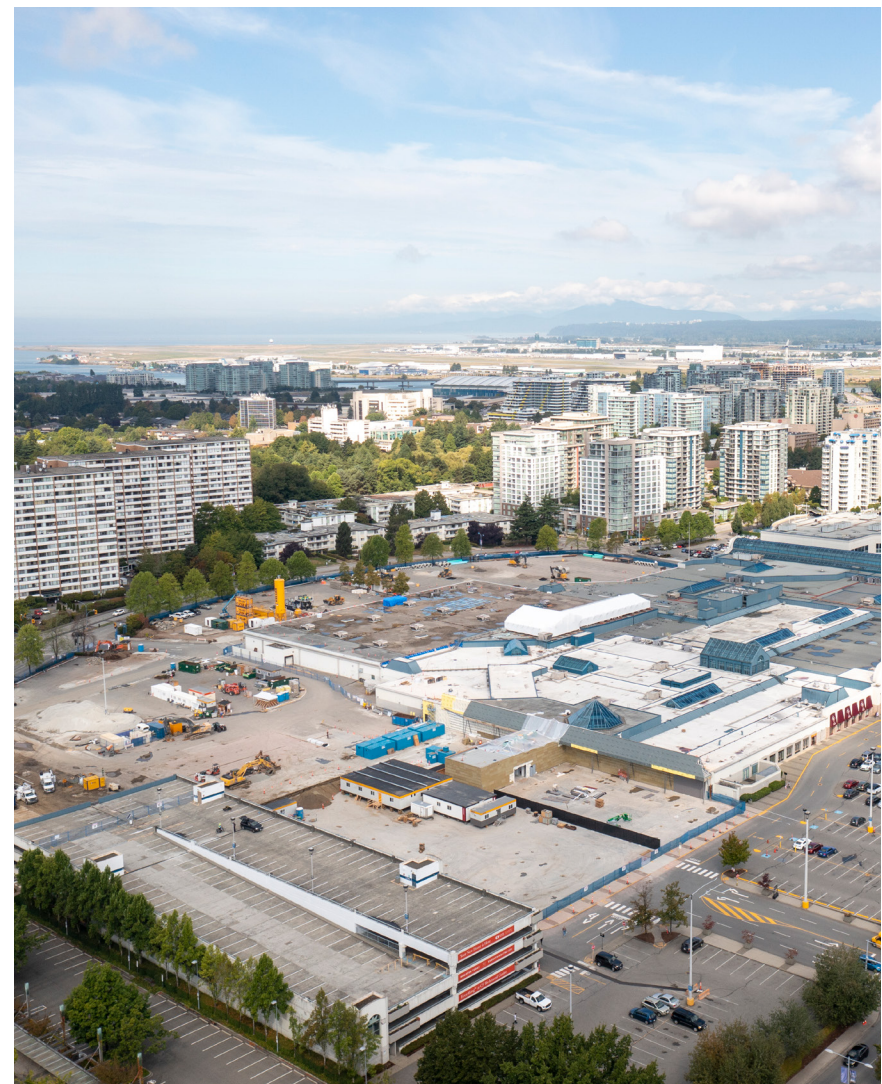
Vue aérienne des travaux à CF Richmond Centre (Richmond, en Colombie-Britannique)
